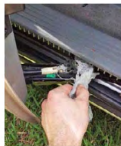
Sering bersihkan jalur rel atas dan bawah sliding door
