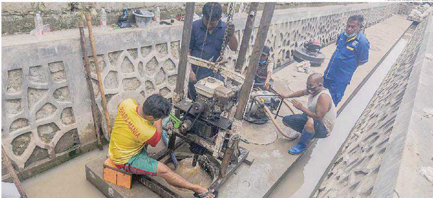
SUMUR RESAPAN Petugas menyelesaikan pembuatan sumur resapan di kawasan Karet, Jakarta Pusat, Kamis (4/3). Pemerintah Provinsi DKI Jakarta baru membuat 3.964 sumur resapan atau 0,2 persen dari target kebutuhan 1,8 juta sumur resapan sebagai salah satu cara menanggulangi banjir dengan pendekatan ekologis.
