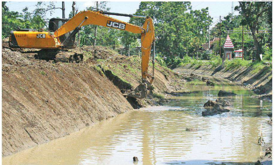
REHABILITASI SALURAN IRIGASI Pekerja mengeruk endapan tanah dari dasar aliran irigasi dengan menggunakan alat berat di Jwan, Madiun, Rabu (17/3). Pemerintah melalui Kementerian Pertanian berupaya memastikan ketersediaan air dalam pertanian dengan program Rehabilitasi Jaringan Irigasi Tersier (RJIT) demi meningkatkan indeks pertanian.
